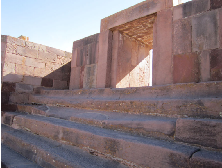
Figura 56 b. Escala Monumental y Portal reconstruido por el CIAT vista desde el exterior
